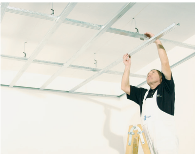
Dupla bordaváz építése
